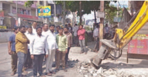
పనులను పరిశీలిస్తున్న డిప్యూటీ మేయర్ ధనరాజ్ యాదవ్
